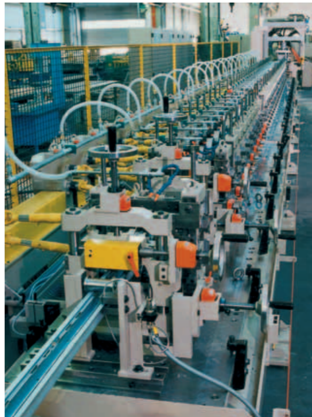
Instalación de perfilado arranque – parada
